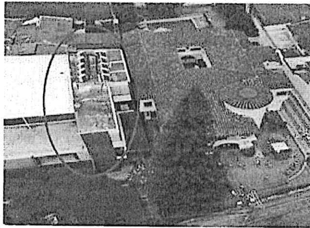
Imagen 15, indica la construcción existente en zona de influencia por cercanía casa Ochoa
