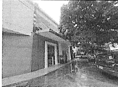
Imagen 8. Imagen exterior, zona de parqueaderos, fuente propia
