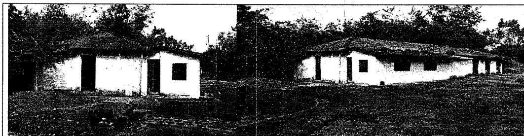
Construcción en el predio destinado a vía Avenida Ciudad Cali, frente al predio de la casa de hacienda El Carmen.
