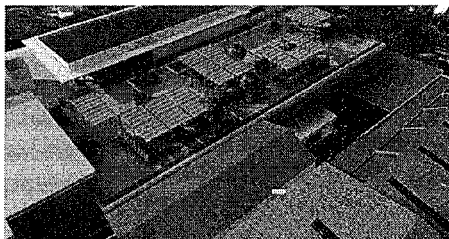
Después (Instalación de estructura reversible con elementos de soporte metálicos y toldos retráctiles) toldos extendidos.
