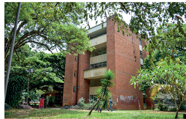
● Aspecto del remate del edificio en donde estaban las zonas de estar y las salas de estudio de los residentes
