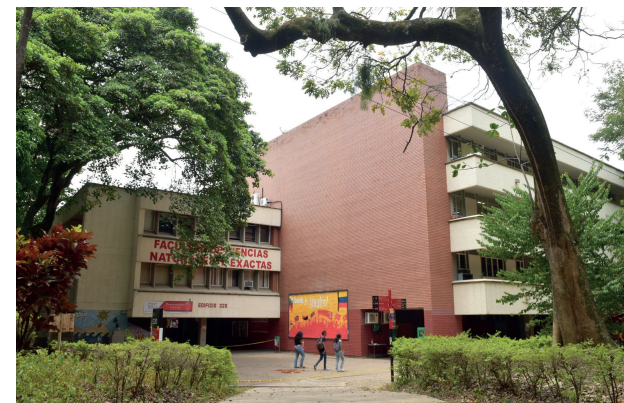
● Acceso por uno de los puntos fijos. Octubre de 2019.
