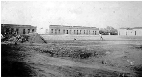
Construcción del Parque, década de 1930, Ebica Deptal
