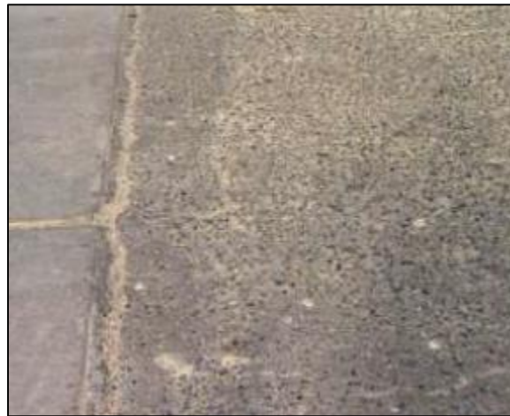
Figura 26. Desgaste.
