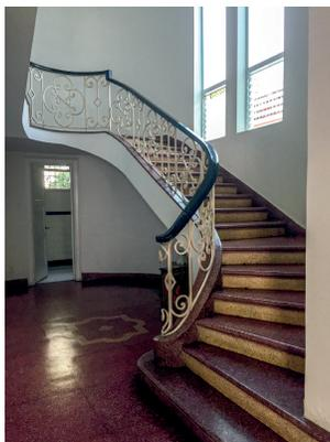
● Escalera de un tramo con entrada y salida de un cuarto de vuelta
